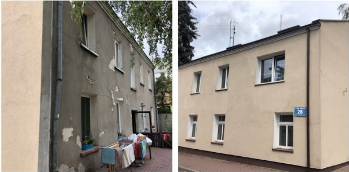
Fot. 1. Elewacja wschodnia – spękania muru, odspojenia i ubytki tynku.
