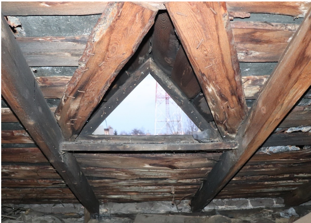
Fot. 8. Więźba dachowa i deskowanie – ślady uszkodzenia pokrycia dachowego z blachy stalowej widoczne wysuszone fragmenty grzybni grzyba domowego ( Serpula lacrymans ) oraz zacieki.
