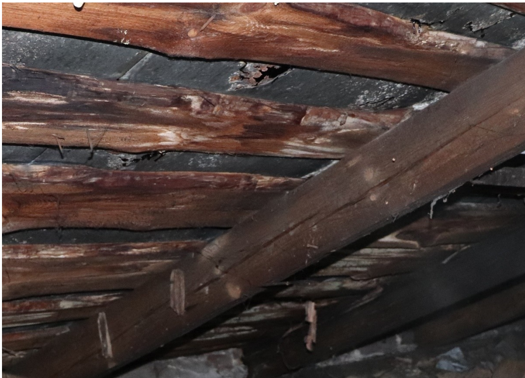
Fot. 8. Więźba dachowa i deskowanie – ślady uszkodzenia pokrycia dachowego z blachy stalowej widoczne wysuszone fragmenty grzybni grzyba domowego ( Serpula lacrymans ) oraz zacieki.
