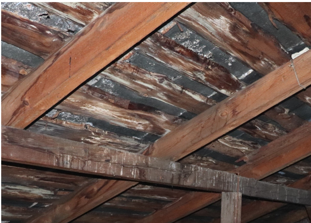
Fot. 6. Więżba dachowa i deskowanie – ślady uszkodzenia pokrycia dachowego z blachy stalowej widoczne wysuszone fragmenty grzybni grzyba domowego ( Serpula lacrymans ) oraz zacieki.
