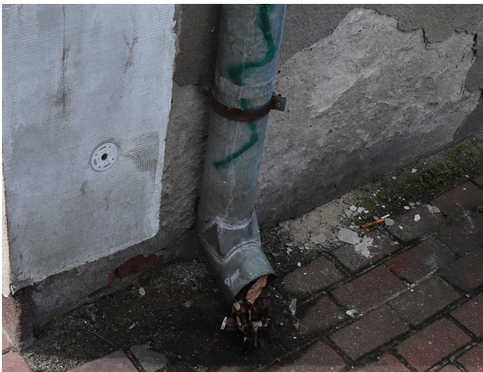
Fot. 5. Elewacja wschodnia – rura spustowa odprowadzająca wody opadowe - widoczne ślady wpływu zawilgocenia i zasolenia - ubytki i zniszczenia tynku w pasie przyziemia.
