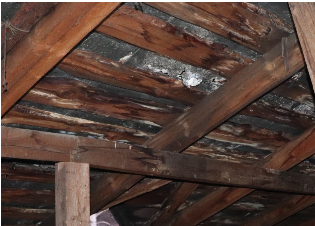
Fot. 6. Więżba dachowa i deskowanie – ślady uszkodzenia pokrycia dachowego z blachy stalowej widoczne wysuszone fragmenty grzybni grzyba domowego ( Serpula lacrymans ) oraz zacieki.
